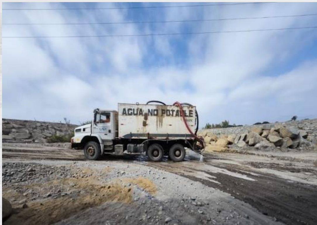
Riego continuo para evitar generación de polvo
