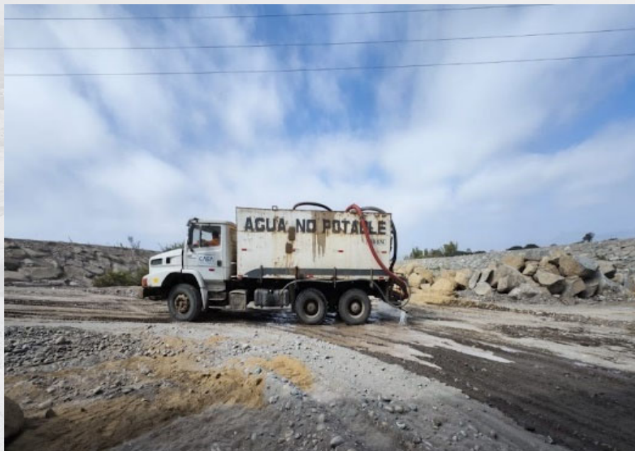
Riego continuo para evitar generación de polvo
