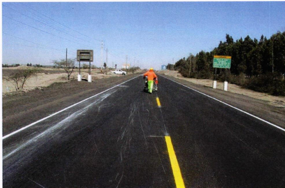
Foto N° 05 y 06: Pintado de Marcas en pavimento
