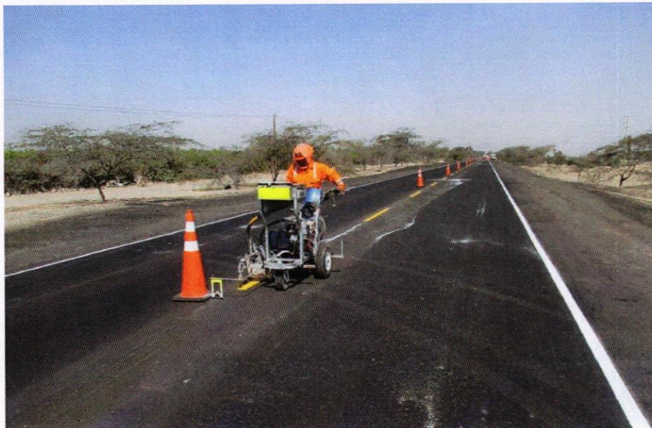
Foto N° 07 y 08: Pintado de Marcas en pavimento
