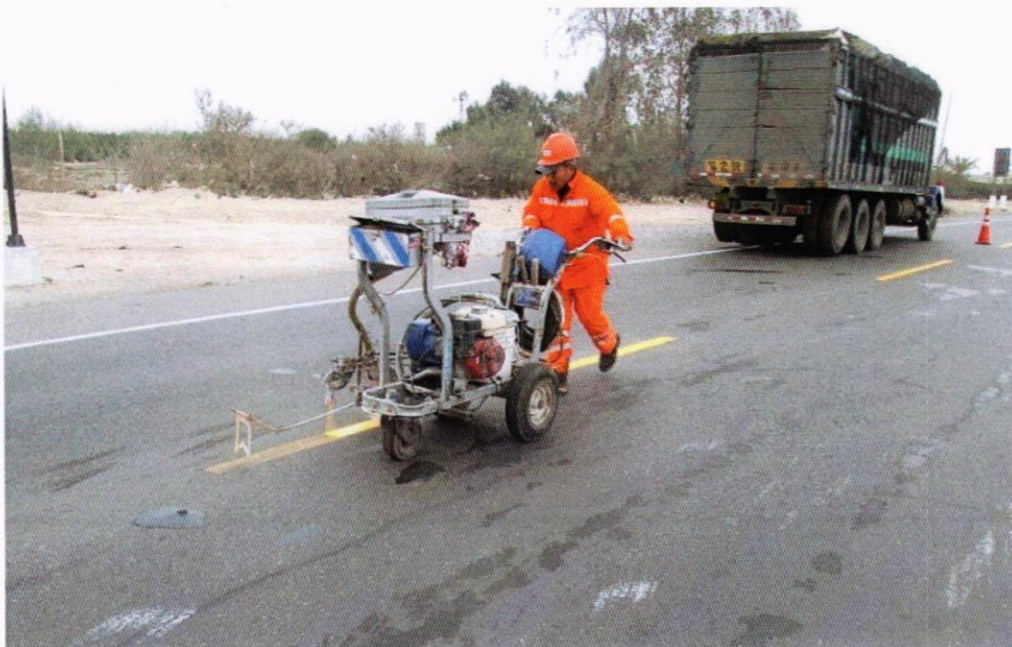
Foto N° 03 y 04: Pintado de Marcas en pavimento
