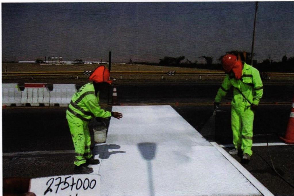
Foto N° 01 y 02: Pintado de Marcas en pavimento Peaje Ica
