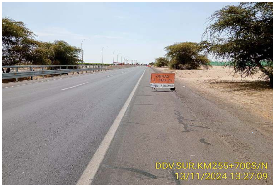
Letrero de obras a 300 metros
